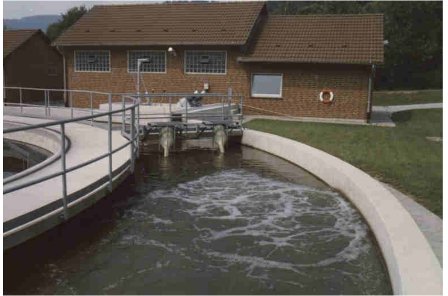
Montage sur passerelle
