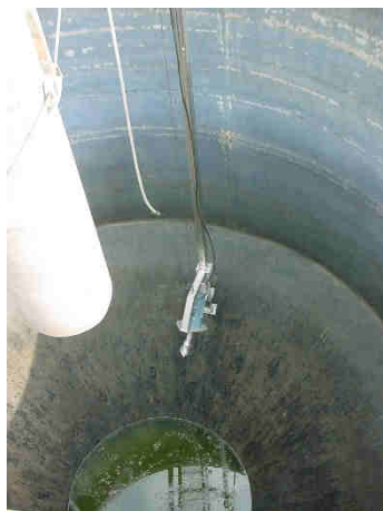
Montage en silo
