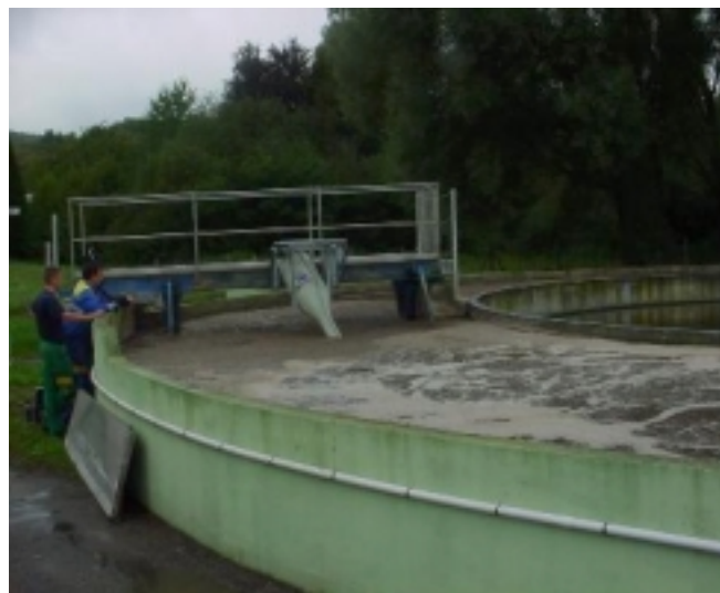
Aérateur en remplacement d'un pont brosse On utilise les poutres de l'ancien aérateur
